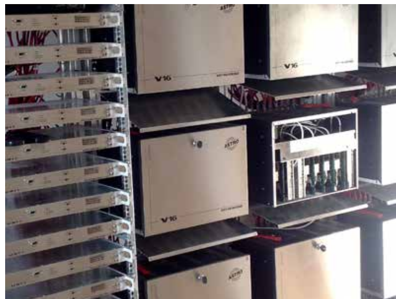
Blick in unsere Kabelkopfstelle in Wilhelmshaven
